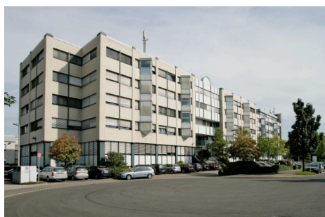
Anlage: Reisholzer Werftstraße 38-44 in Düsseldorf
