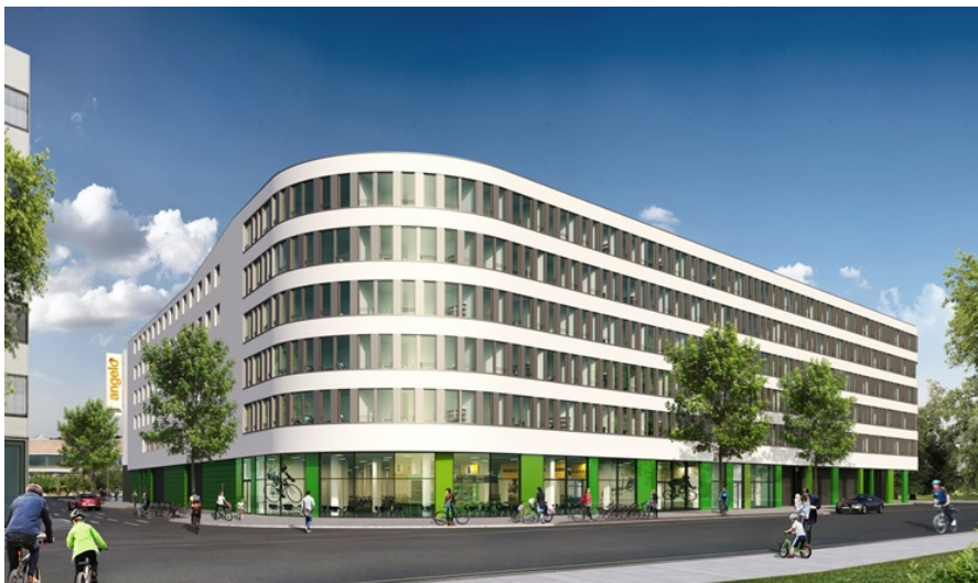
Büro- und Einzelhandelsgebäude Leuchtenbergring, Westansicht © Münchner Grund
